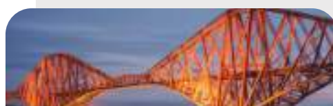
برخی از سازه‌های پل فلزی خرپایی
