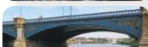
برخی از پل‌های تیرورقی
