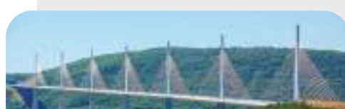
برخی از پل‌های کابلی
